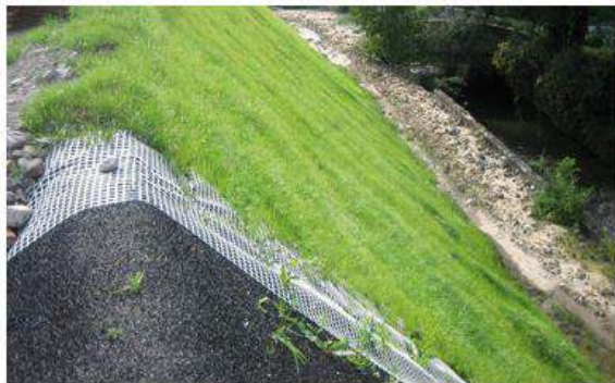
Рис. 7. Укрепление склона травянистой дернообразующей растительностью
